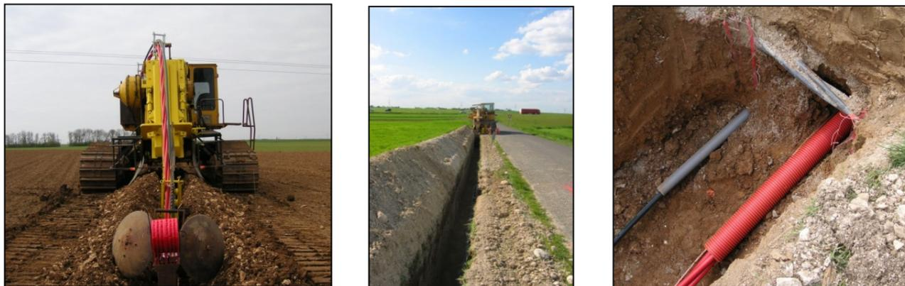
Le réseau électrique externe relie le poste de livraison avec le poste source du réseau public de distribution d'électricité. Généralement, il est enterré ou semi-enterré. Le réseau externe est réalisé sous maîtrise d'ouvrage du gestionnaire de réseau de distribution d'électricité. Le raccordement du parc éolien de Boissy-la-Rivière 3 est envisagé au poste source des MORIGNY à Morigny-Champigny situé à 6 km environ par la route.
