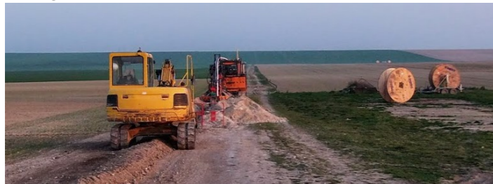
Figure 81: Exemple de travaux pour l'installation du raccordement enterré
