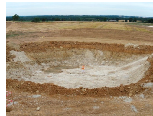
Figure 78 : Exemple de fondation excavée et remblais
