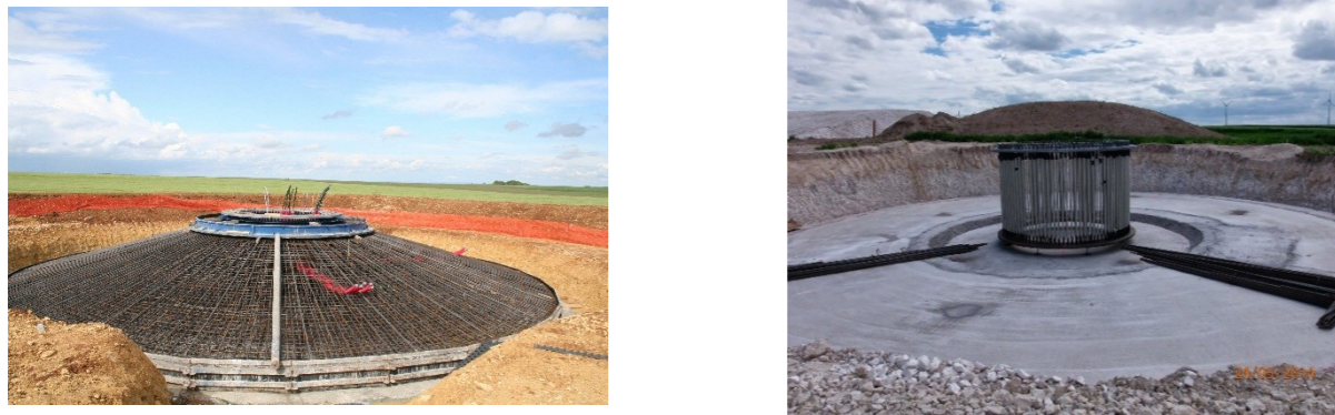
Figure 79 : Exemples de ferrailage et coulage des fondations
