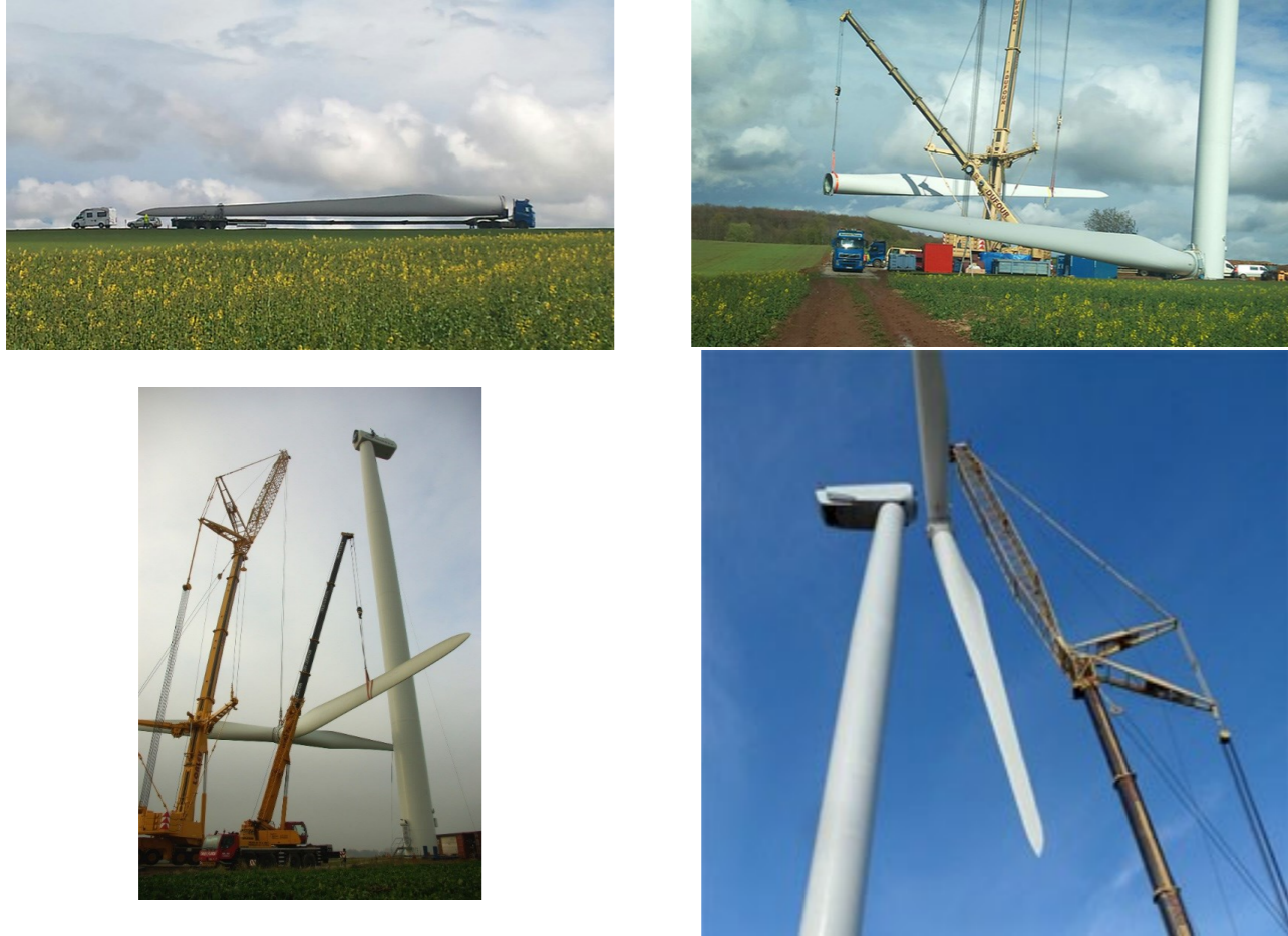
Figure 80 : Exemple de séquences d'assemblage d'une éolienne
