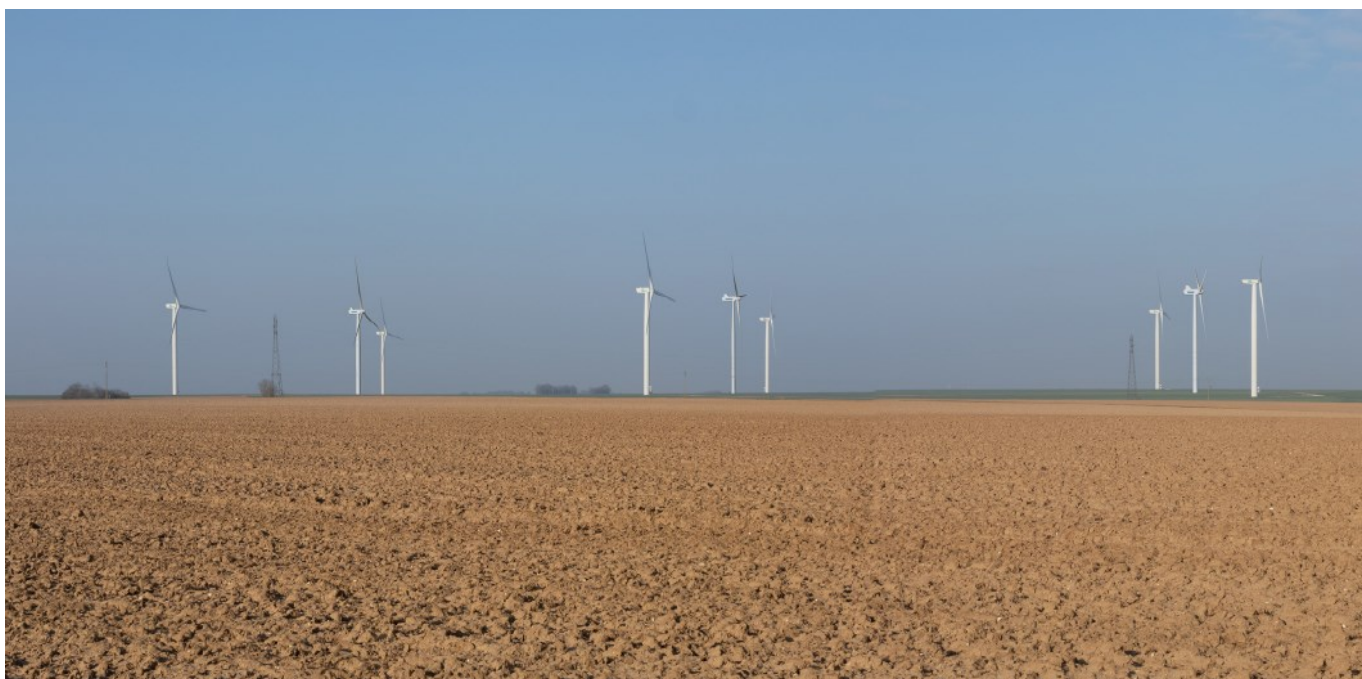
Figure 6 : Vue du parc éolien de Boissy-la-Rivière 3 depuis le sud de Mesnil-Girault, dans l'aire rapprochée
