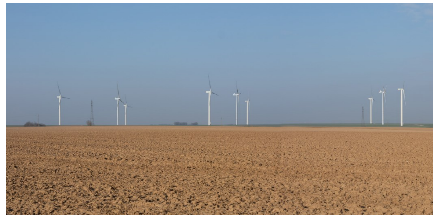
Figure 13 : Vue du parc éolien de Boissy-la-Rivière 3 depuis le sud de Mesnil-Girault, dans l'aire rapprochée
