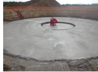
Fosse d'excavation finalisée avec profil doux
