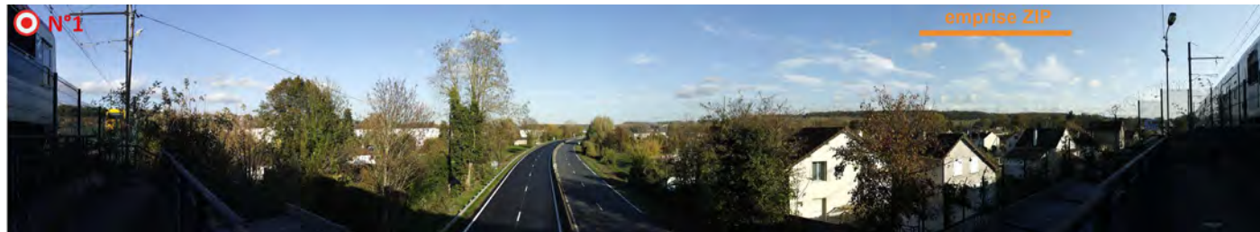
Illustration 21 : vue depuis la voie ferrée au-dessus de la RD194
