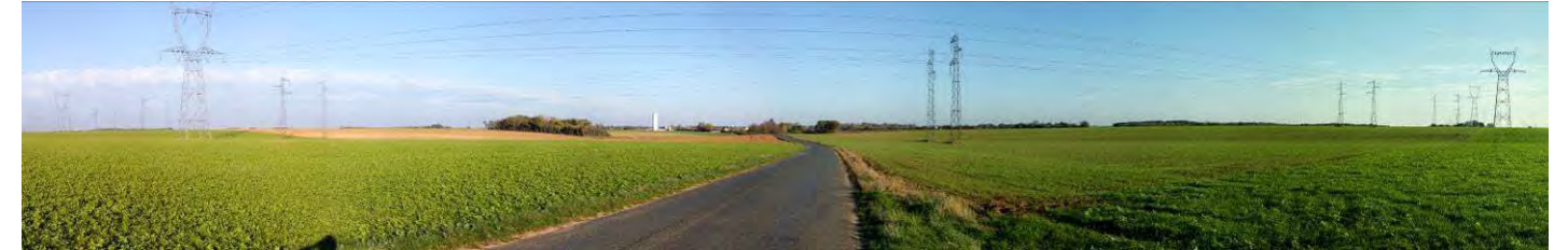
Illustration 5 : Pylônes électriques sur le plateau agricole
