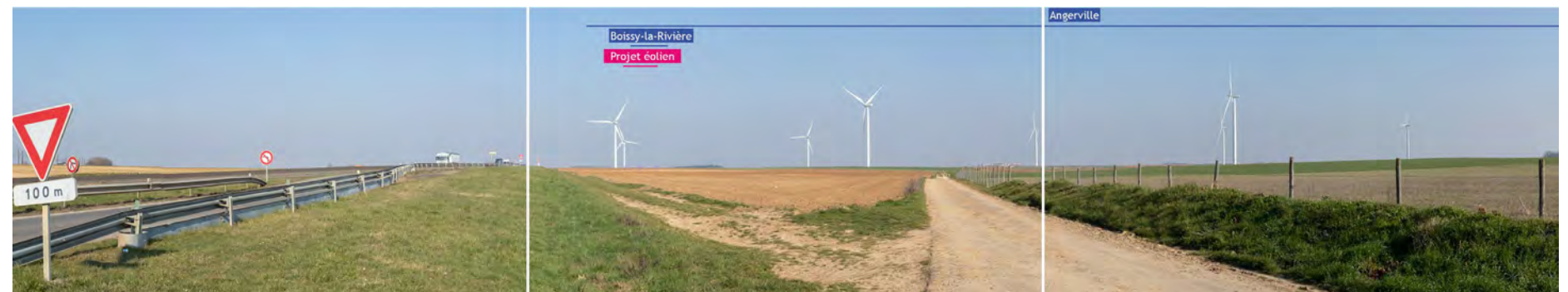
Illustration 58 : PDV N° 3 - RN20 en sortie nord d'Angerville
